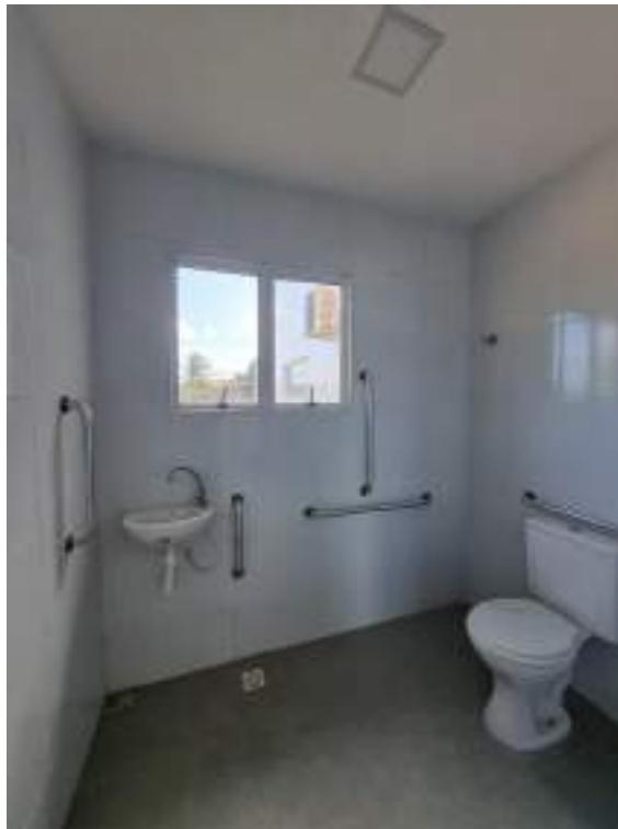
Imagen: Banheiro Acessível – Piso em porcelanato, barras de apoio para acessibilidade, revestimento cerâmico nas paredes
