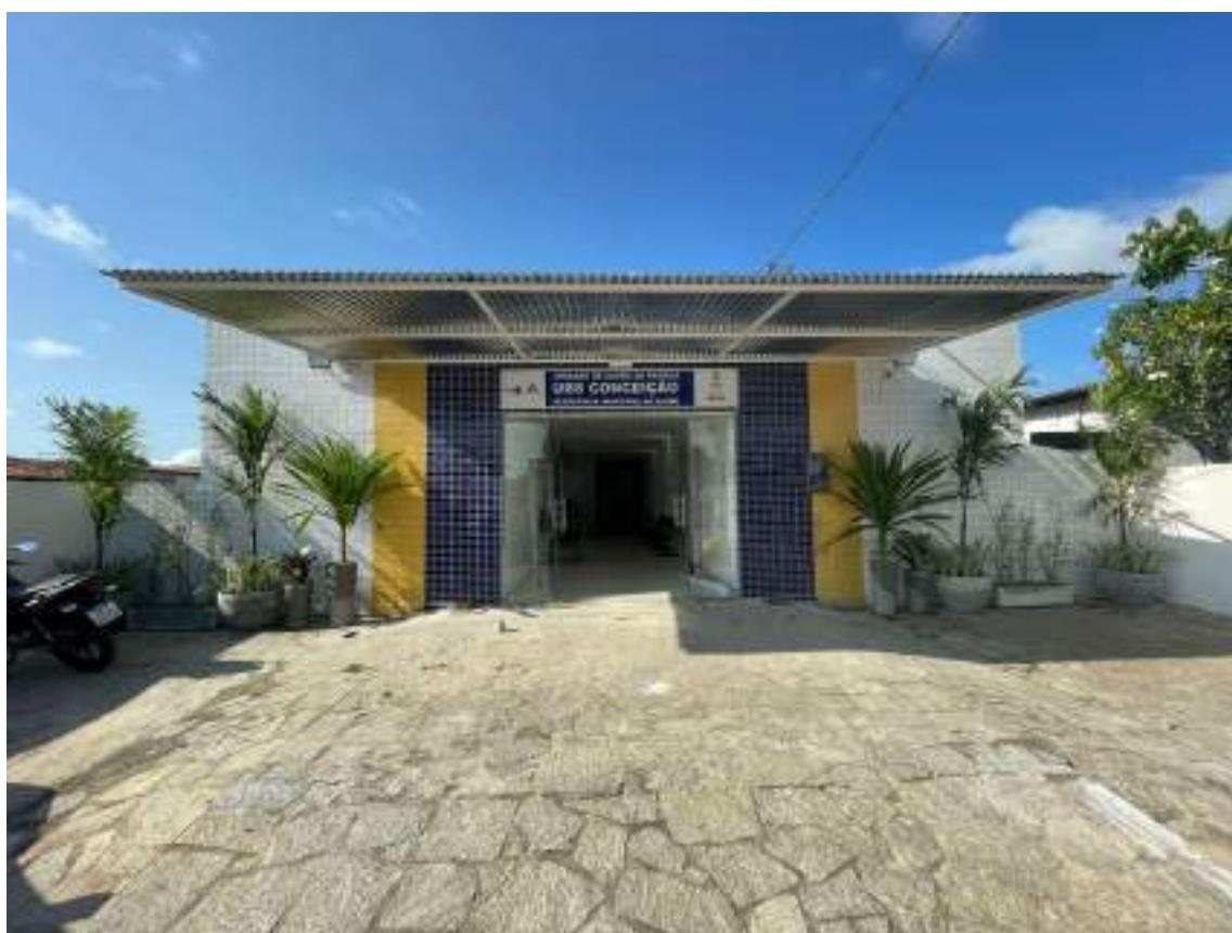
Imagen: Fachada frontal da UBS Conceição – Marquise metálica, revestimento cerâmico nas fachadas
